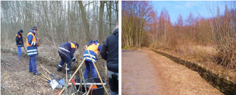
Lehrlinge der Wasserbauschule beim Bau eines Weidenflechtzauns
